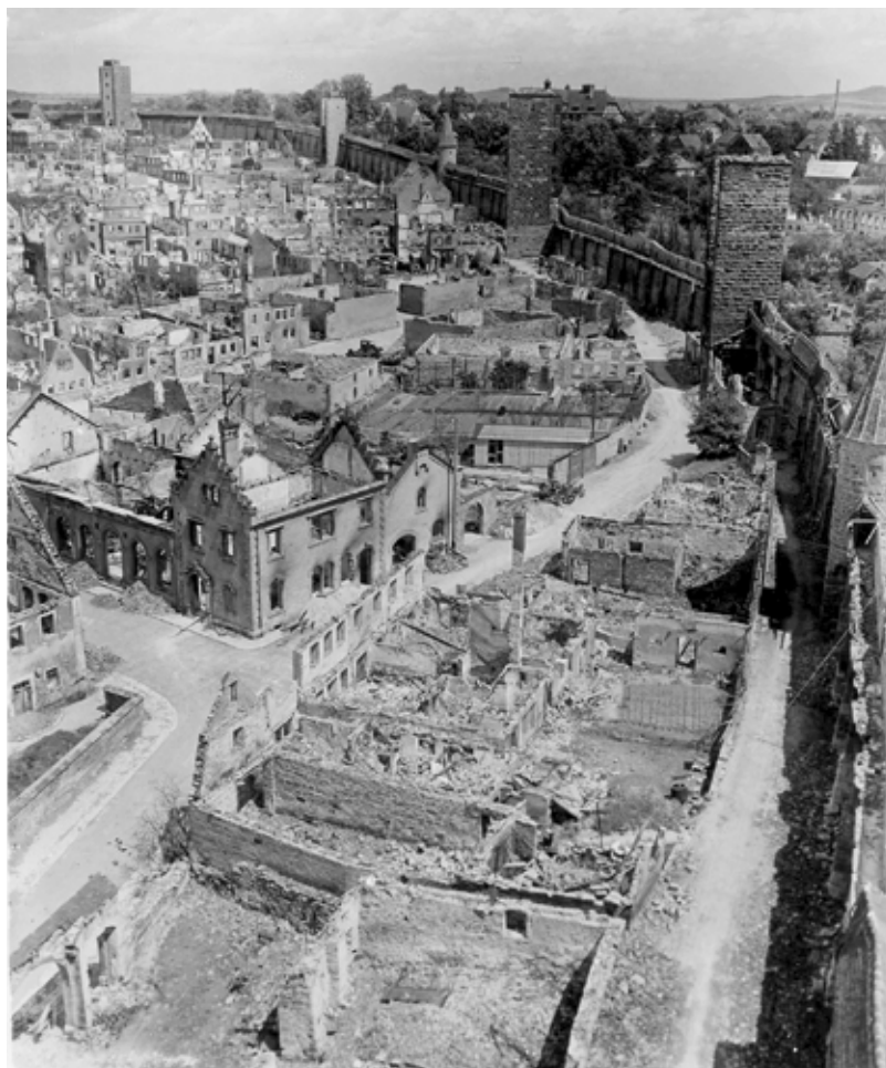
25 Blick vom Faulturm auf den kriegszerstörten Bereich, 1945
